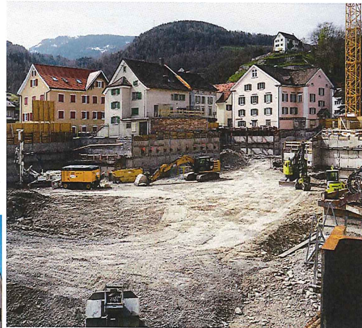
Imposante GKZ-Baugrube: Die Baugrubenarbeiten stehen kurz vor ihrem Abschluss, und nun stehen Tiefbau- und Baumeisterarbeiten an, um die geplante Tiefgarage zu realisieren.
