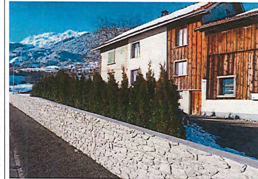
Von September bis November erstellt: Die neue Stützmauer (unten) erinnert durch ihre Steinmaueroptik an die alte Stützmauer (oben).
